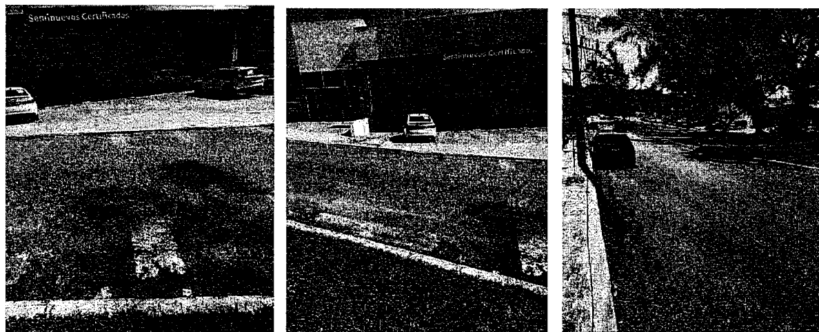
Ilustración 17 Condición del señalamiento horizontal en Av. Revolución (zonas con pérdida de demarcación). Fuente: Elaboración propia (levantamiento en campo, 2025).
