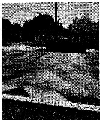
Ilustración 15 Condición del señalamiento horizontal en Av. Álvaro Obregón (marcas con desgaste avanzado). Fuente: Elaboración propia (levantamiento en campo, 2025).
